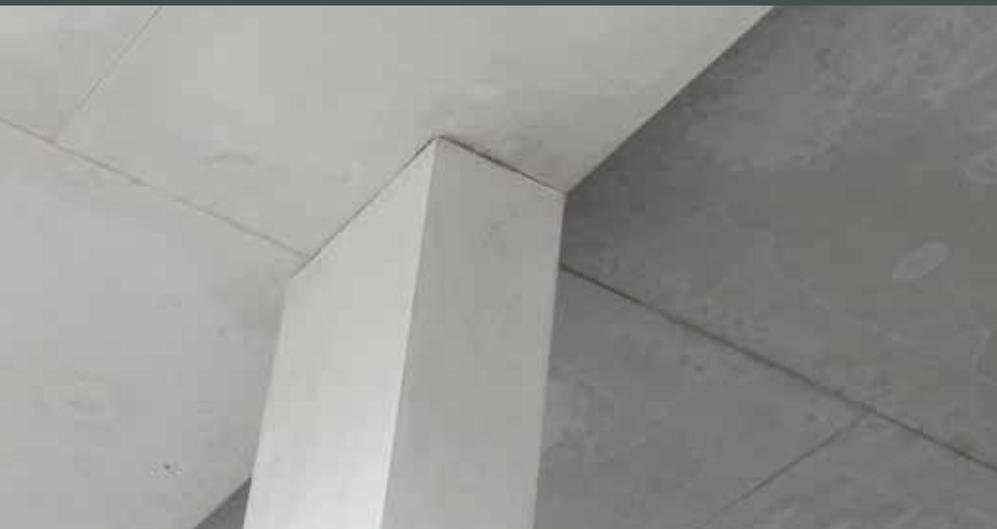
**Magnoply MF** ist für glatte, fugenarme Betonoberflächen nach DIN 18202/3 Zeile 5/6 geeignet. Es können matte, planebene Oberflächen erzielt werden.
